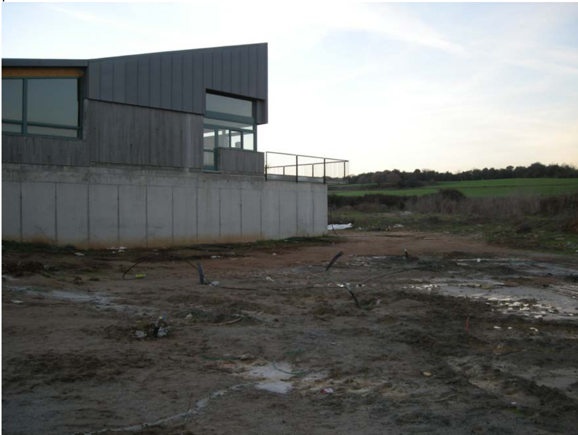
Zona de perforacions, on s'observa la sortida dels bescanviadors tèrmics, abans de conduir-los a la sala de màquines
